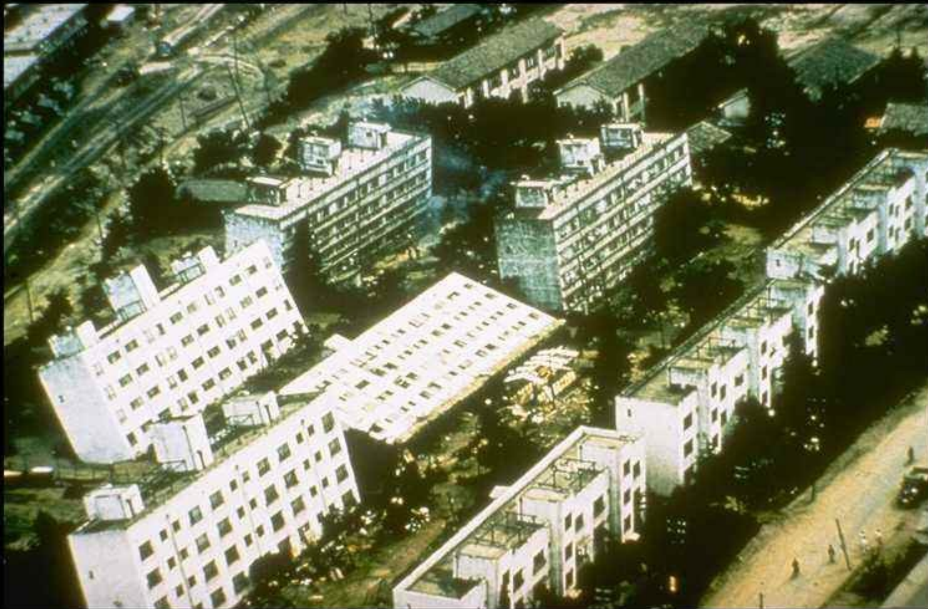
Effets de liquéfaction du sol, séisme de Niigata, Ms=7,5, 16 juin 1964, Japon
